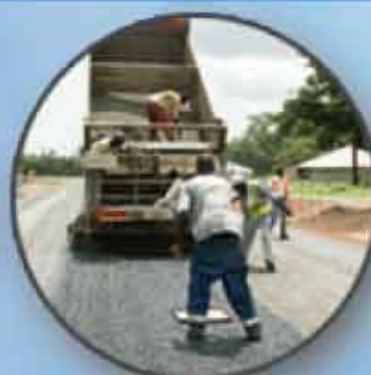
Aménagement de chaussées
